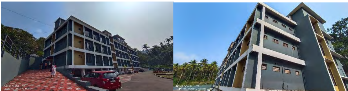
Fig 18.1 Mini Civil Station at Vellarikkund
